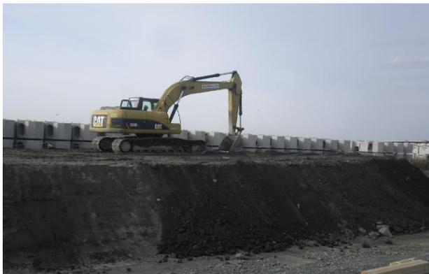
図-20 養生1日で0.7m<sup>3</sup>級BHによる締固めが可能
