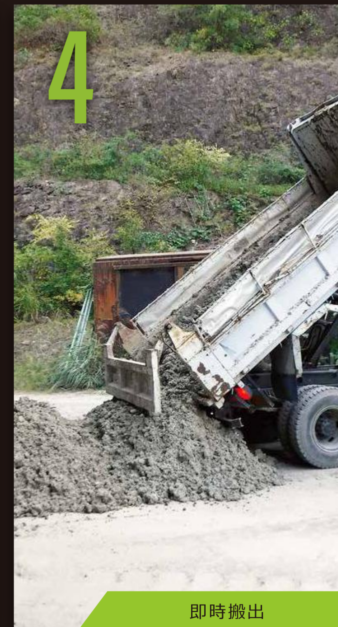
ダンプトラックに積み込み
