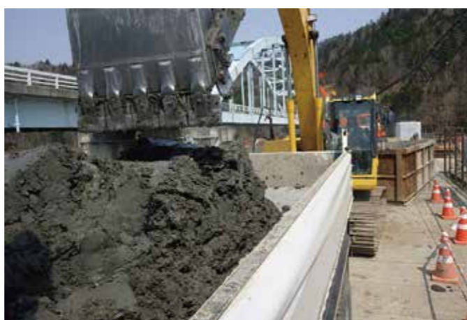
ダンプトラック積込み
