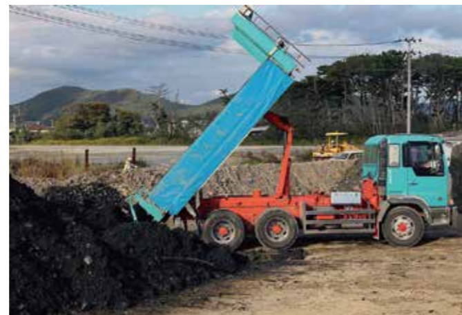
処理土排出状況
