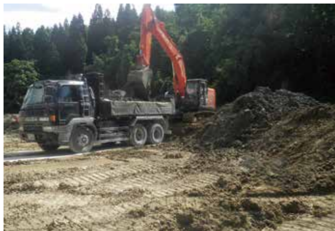
ダンプトラック積み込み
