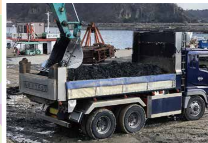
ダンプトラック積み込み
