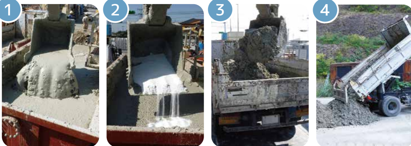
1 高含水泥土発生
