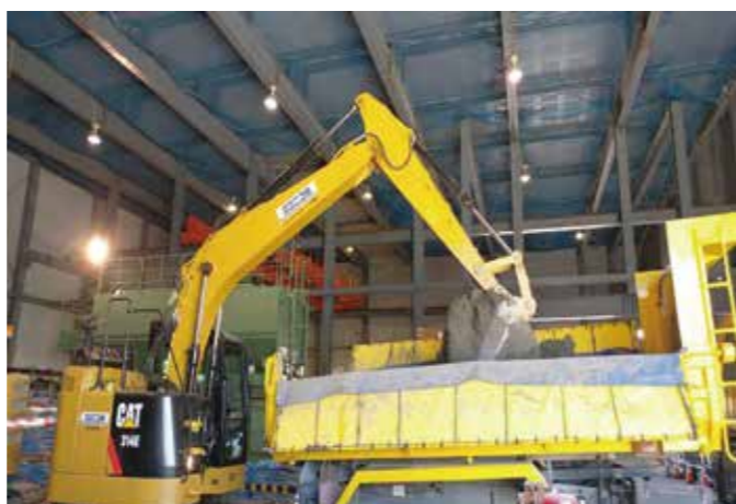
ダンプトラック積み込み
