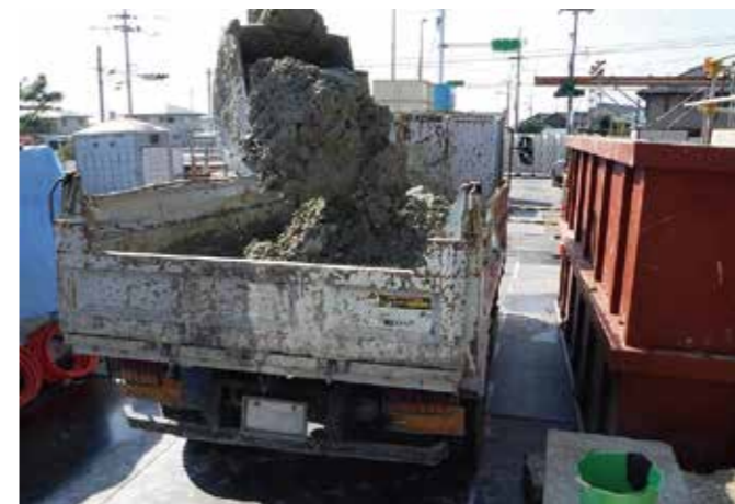
ダンプトラック積み込み
