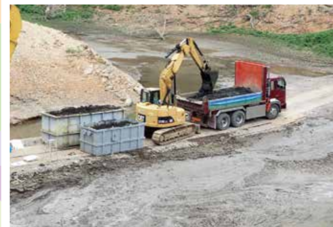
ダンプトラック積み込み
