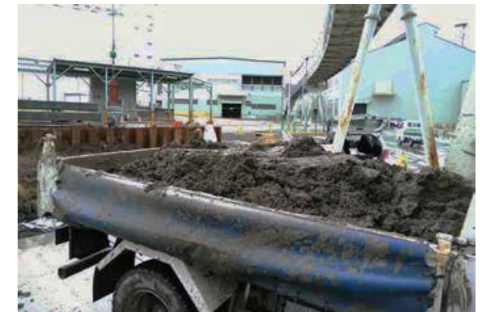
ダンプ積み込み完了
