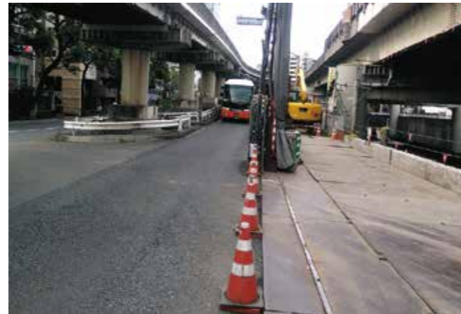
狭小な現場状況
