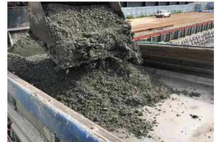
ダンプトラック積み込み状況
