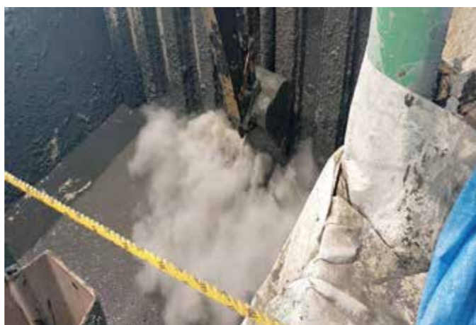
セメント系固化材添加・混合
