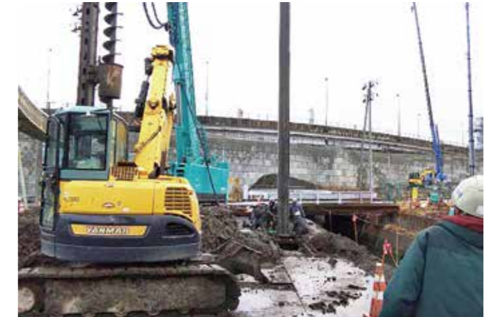
杭打設位置調整
