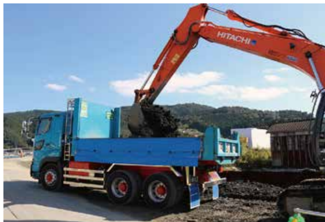
処理土積み込み状況
