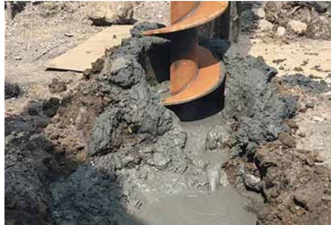
高含水泥土発生
