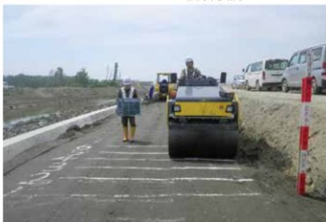
他工事（五間堀川）で築堤盛土として再利用
