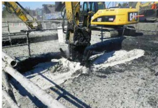
改良状況（セメント系固化材混合）
