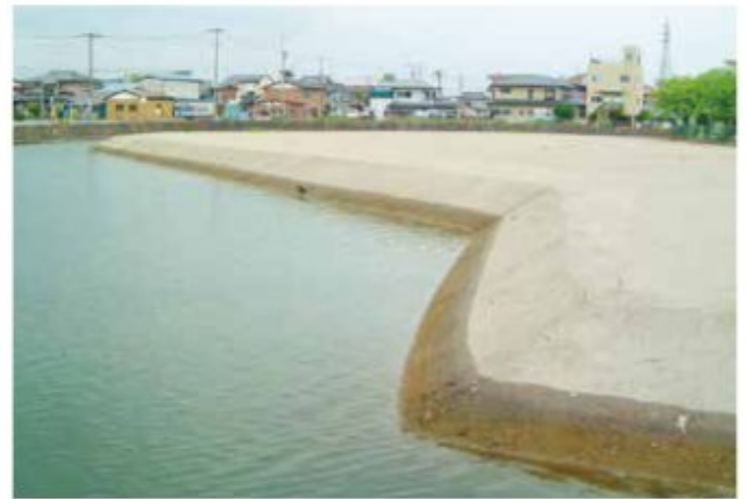
盛土完成（水に接した状態で1年経過、ガリ浸食が一切無い）
