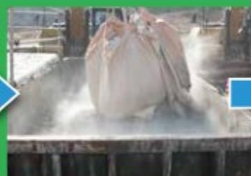
固化材投入・攪拌
