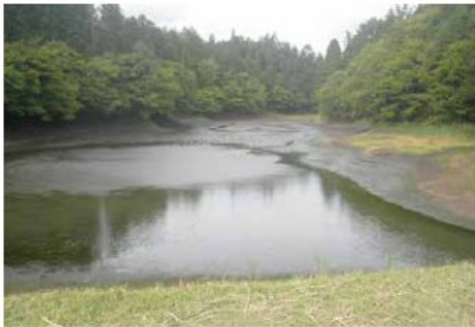
底泥土の堆積状況
