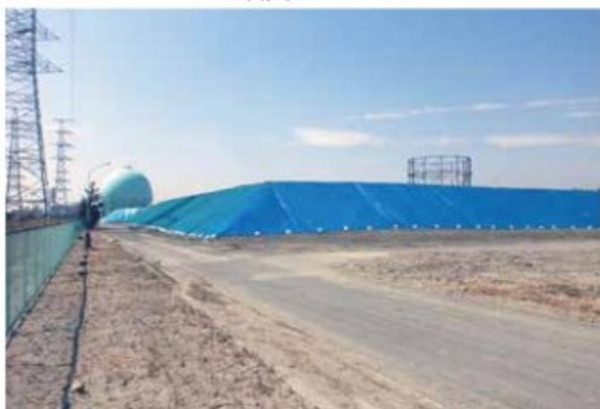
改良土仮置き状況
