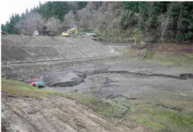
底泥土の堆積状況
