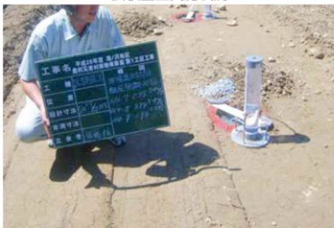
改良土品質確認 (現場透水係数)
