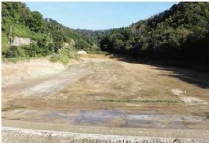
底泥土除去後の状況
