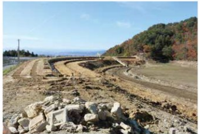
既設堤体段切り状況
