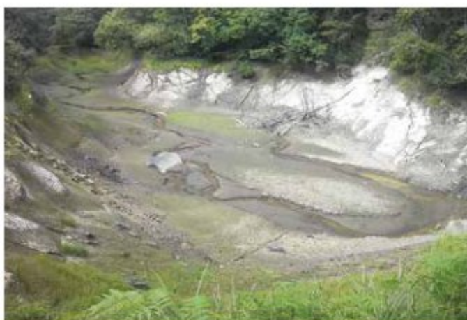
底泥土の堆積状況
