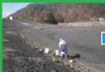
底泥土または堤体掘削土
