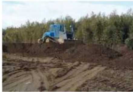
敷均し・転圧
