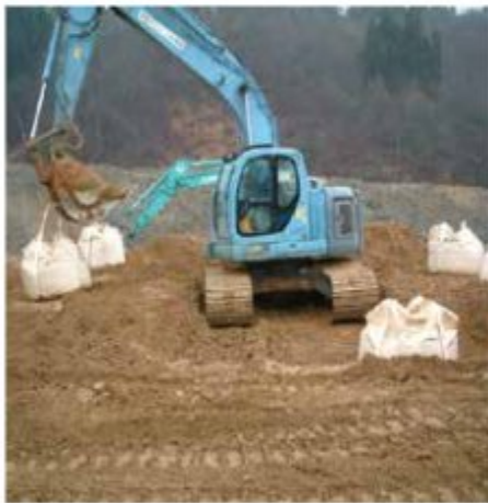
セメント添加状況
