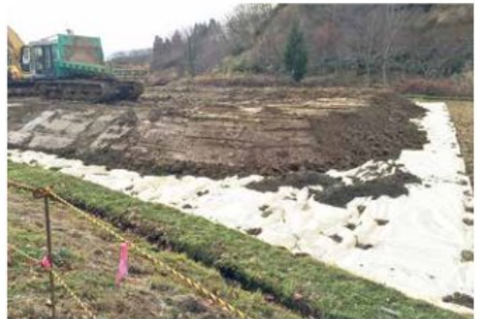
改良土の仮置き・整形状況
