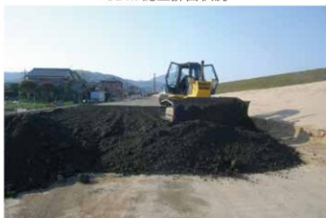
ポンテラン改良土数均し状況
