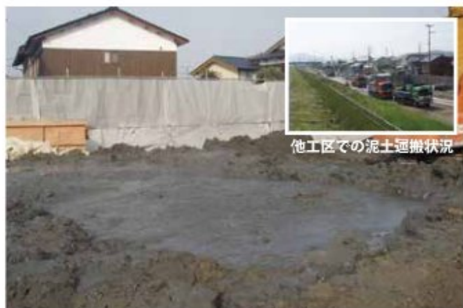
CDM 泥土排出状況
