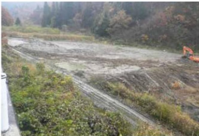
底泥土の堆積状況
