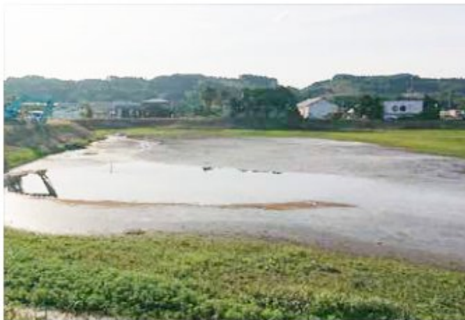
底泥土の堆積状況
