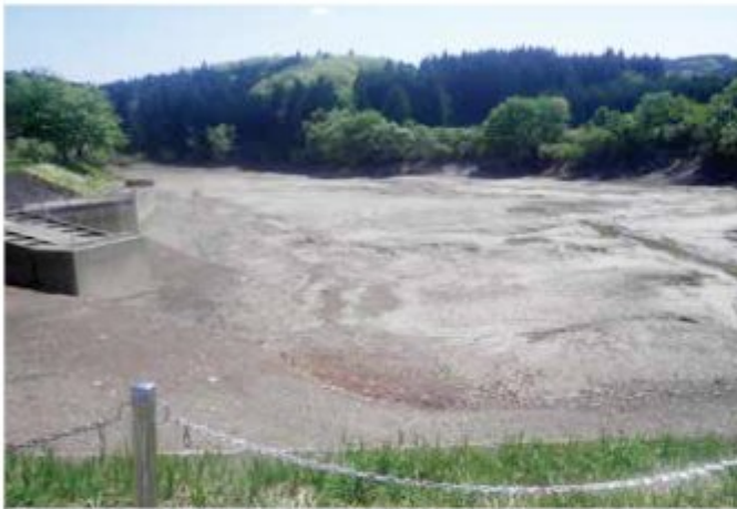
底泥土の堆積状況
