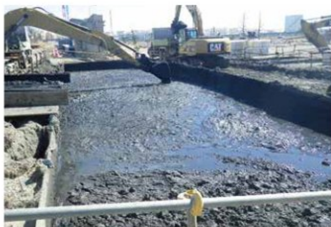
掘削土の状態（ヘドロ状）
