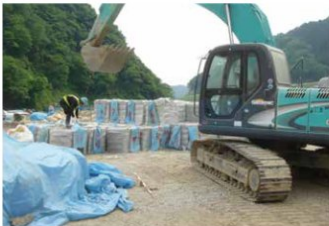
ポンファイバー投入
