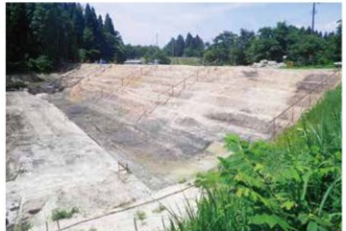
本施工 段切り完了
