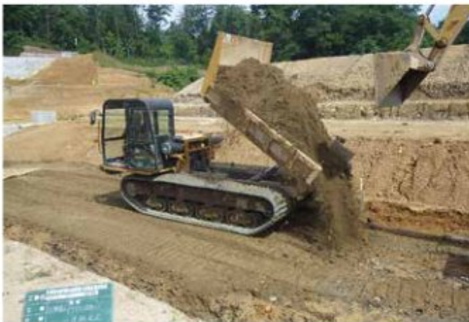
改良土運搬状況
