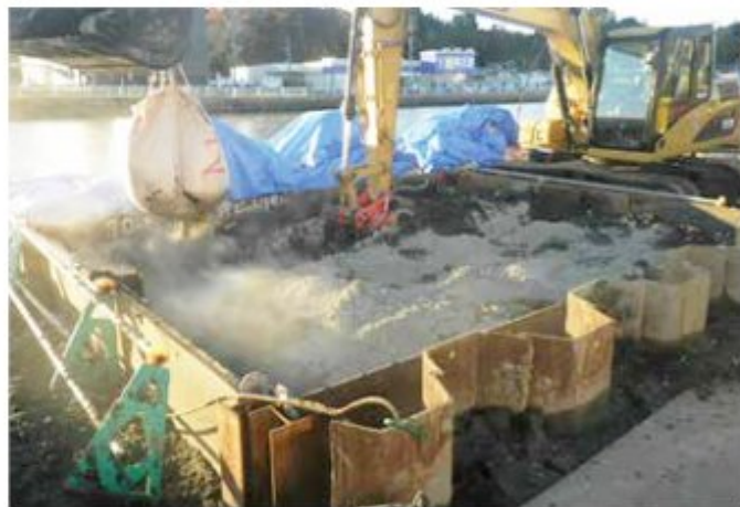
セメント系固化材混台状況
