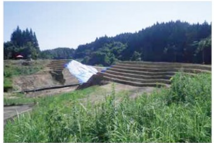
既設堤体段切り状況
