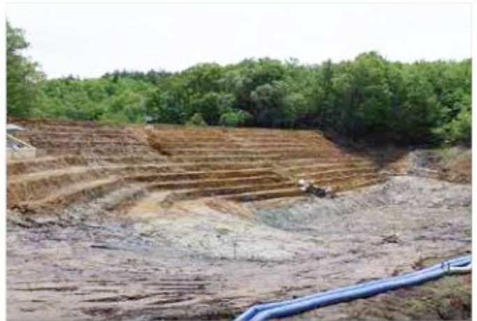
既設堤体段切り状況
