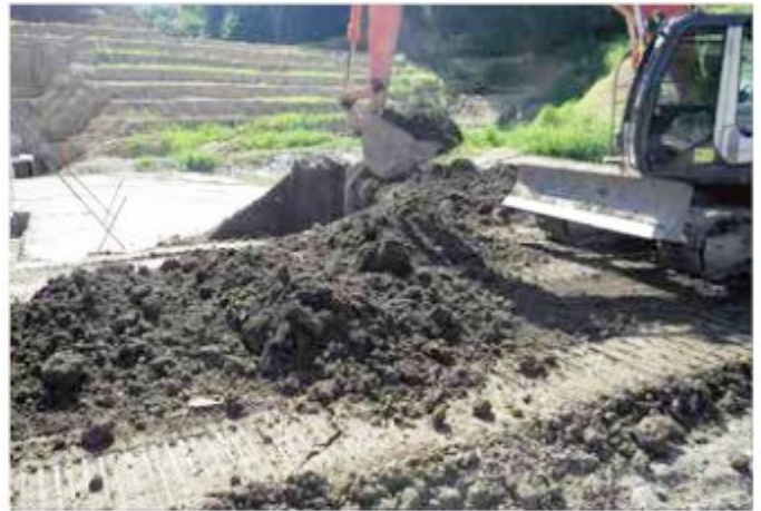
敷き均し状況
