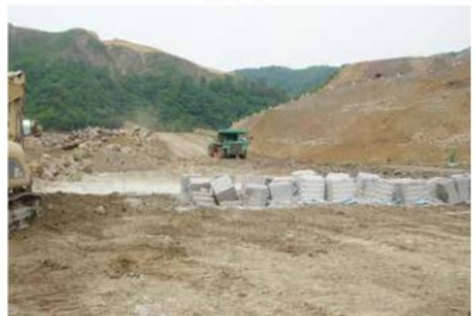
工事用道路に再利用
