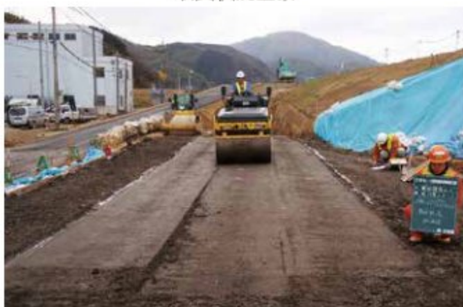
締固め状況
