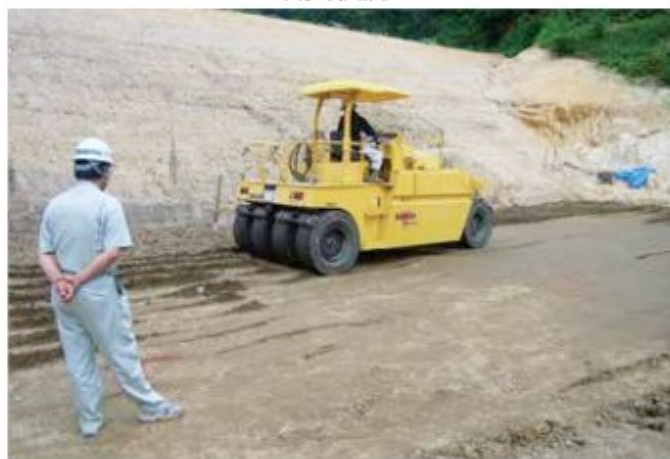
本施工 刃金土敷均し・締固め状況
