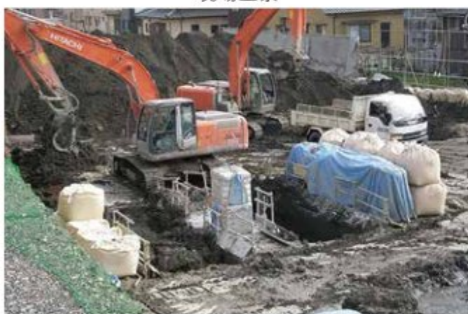
改良状況全景
