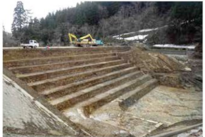
既設堤体段切り状況
