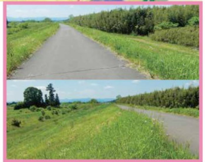
【震災後、ポンテラン改良土を用いた施工箇所】 被害無し
