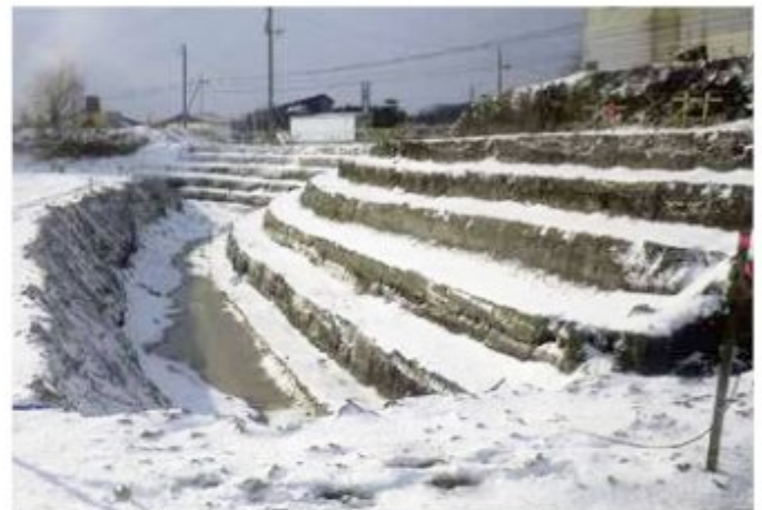
既設堤体段切り状況
