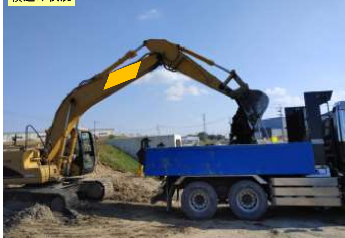
積み込み状況
