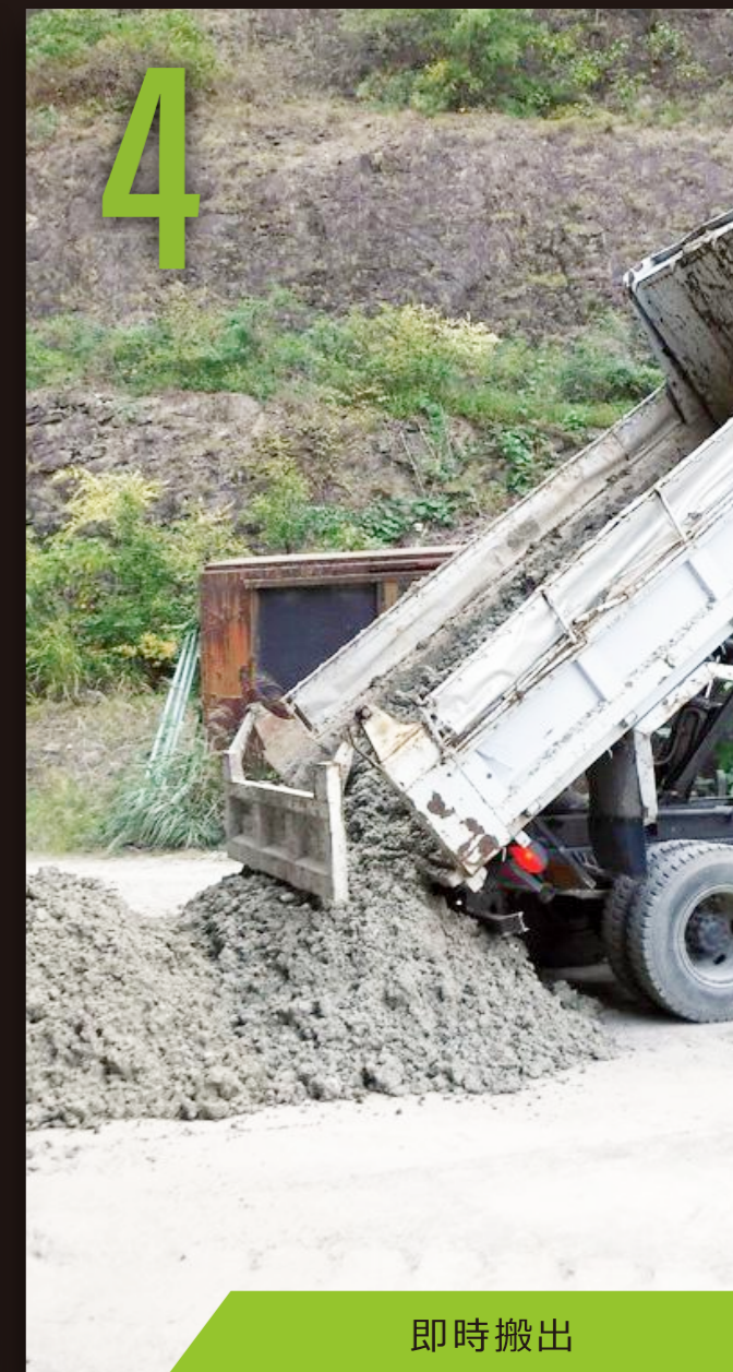
ダンプトラックに積み込み
