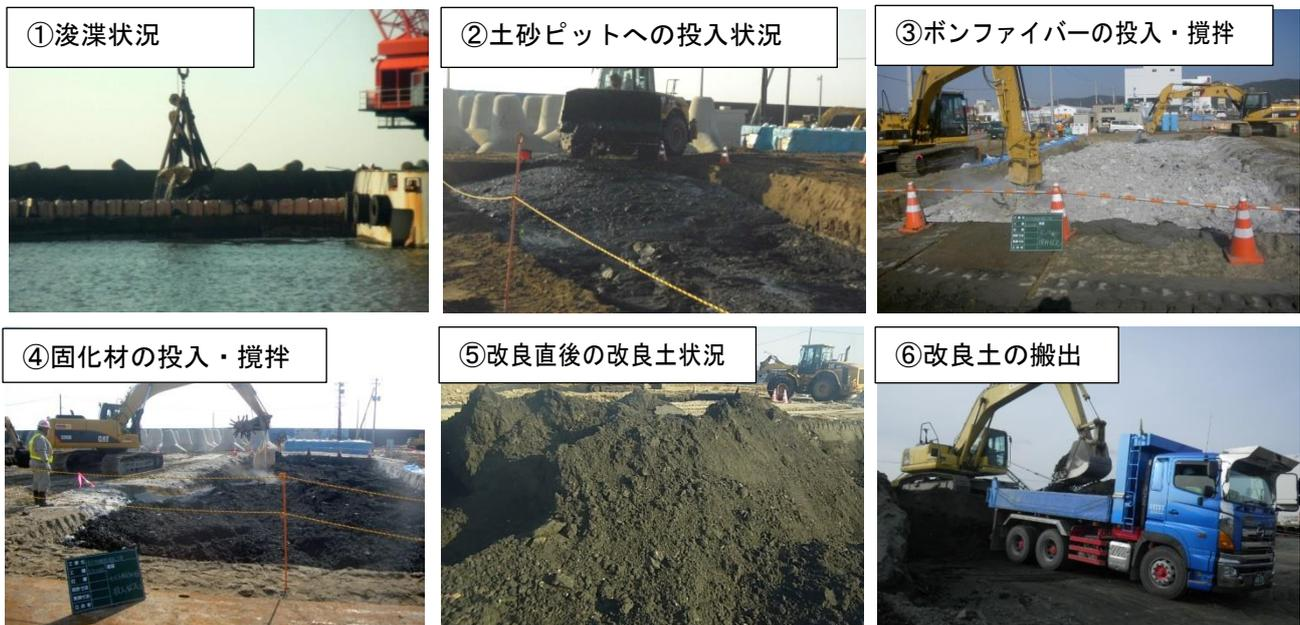
写真-6 改良直後に運搬可能な性状の改良状況
