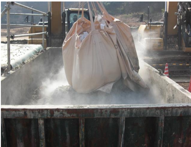
③ セメント等の固化材投入、攪拌
