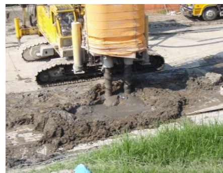
地盤改良、推進工事等から発生する建設汚泥
