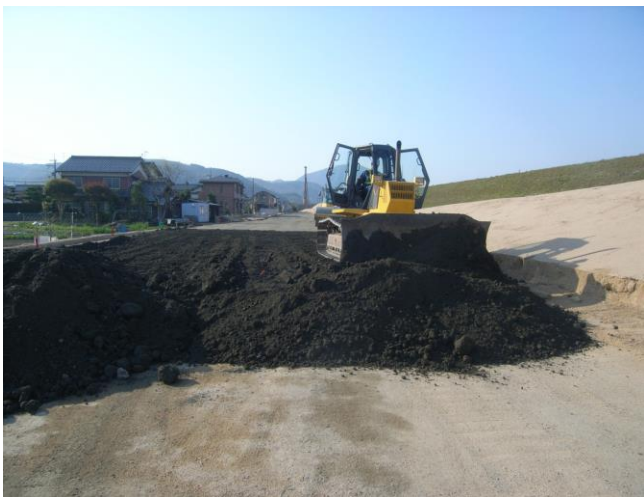
⑤ 改良土の敷均し、締固め
