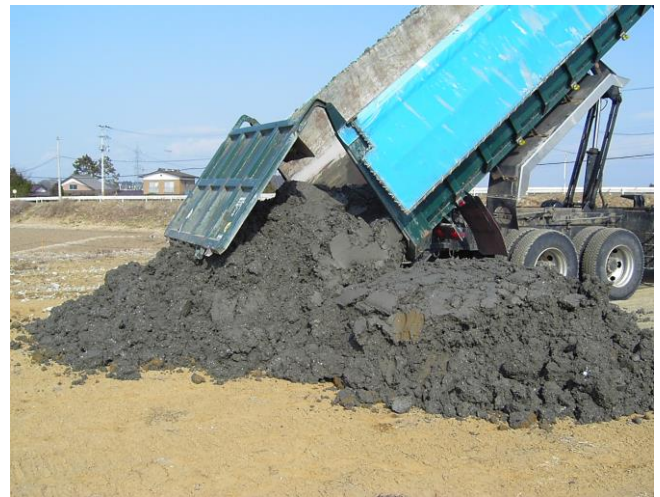
④ 改良土の搬出、養生
