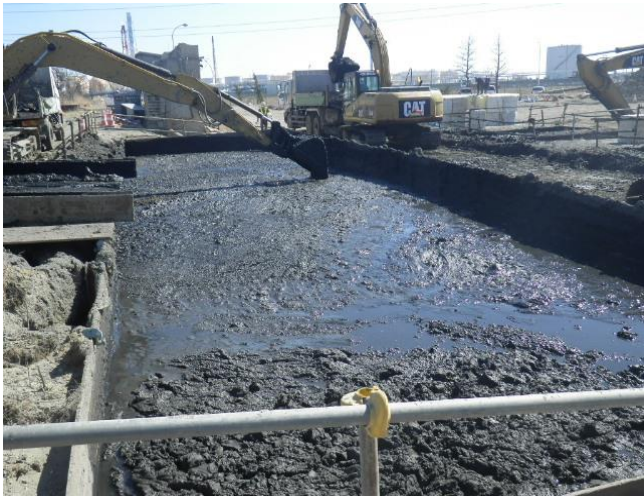
① 高含水泥土を攪拌ピットに集積
