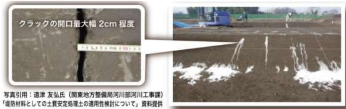
図-1 盛土のクラック発生状況
