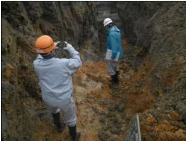
写真-2 改良対象土の確認
