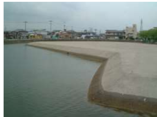
ボンテラン改良土の水際利用(浸食なし)
