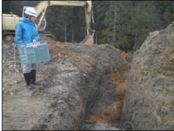
写真-1 改良対象土の掘削状況
