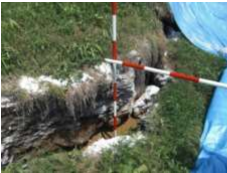
砂質土を用いた堤防
