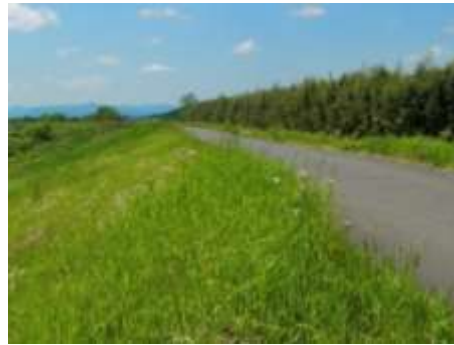
ボンテラン改良土を用いた堤防
