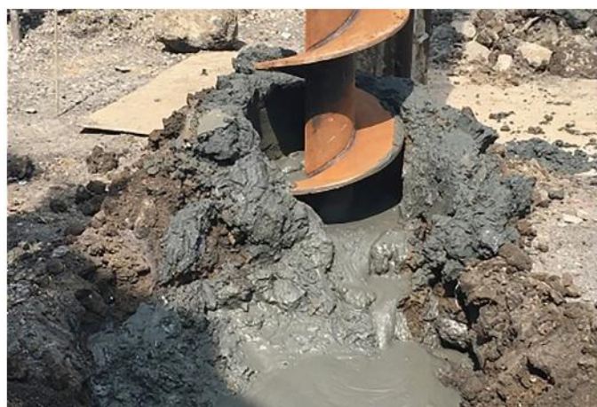
高含水泥土発生
