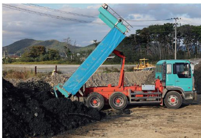
処理土排出状況
