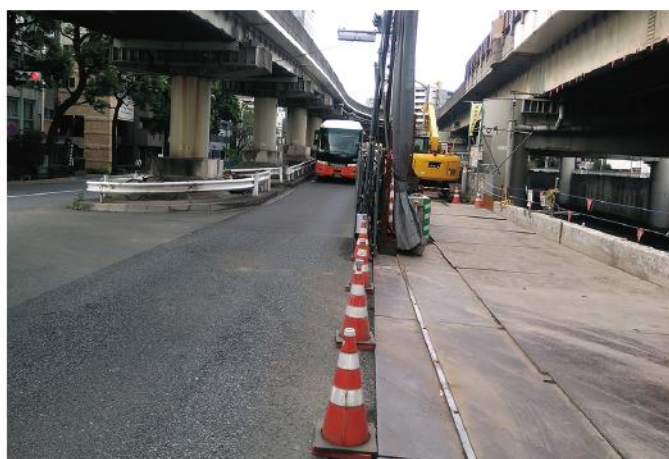
狭小な現場状況
