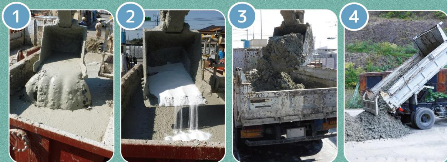
高含水泥土発生
