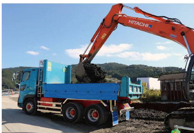
処理土積み込み状況
