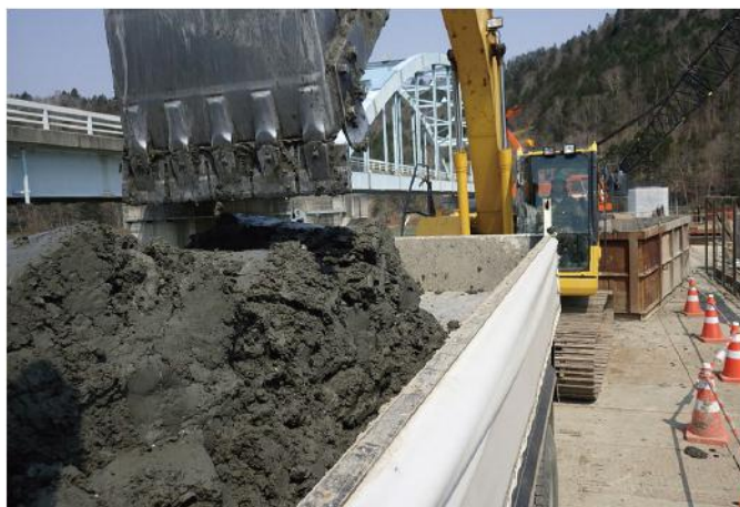
ダンプトラック積込み
