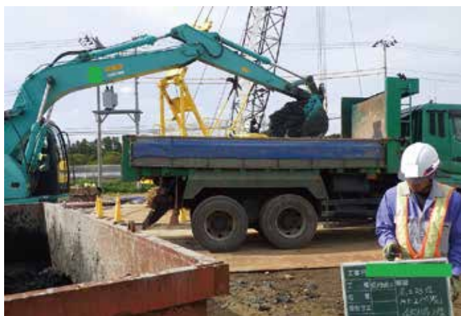
ダンプ積み込み状況
