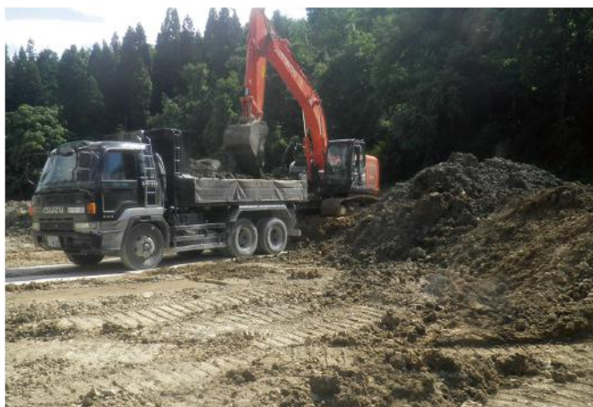
ダンプトラック積込み
