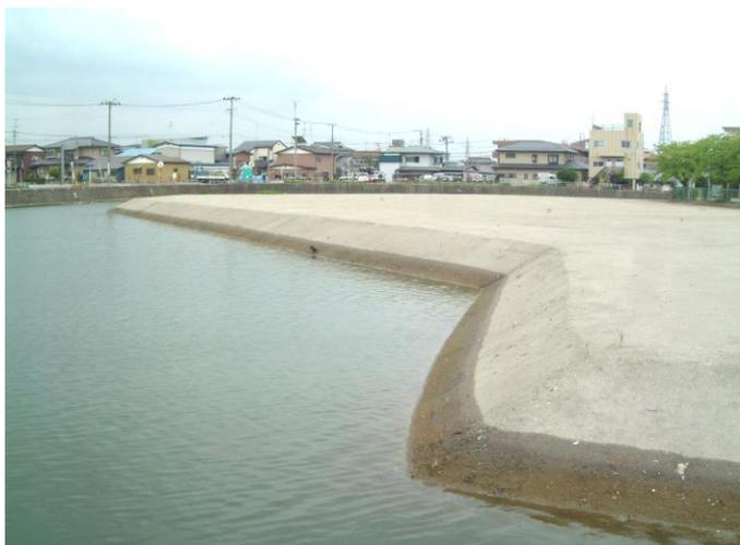
基盤盛土完成(水に接した状態で1年経過、ガリ浸食一切なし)
