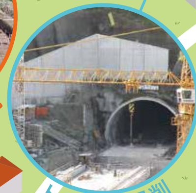
地盤改良・基礎杭
