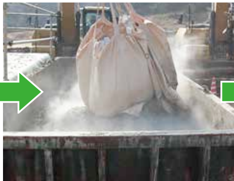
固化材投入・攪拌
