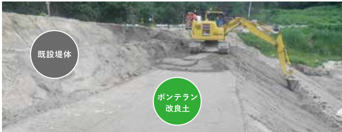
ボンテラン改良土と既設堤体の施工状況
