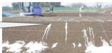
安定処理土のクラック発生状況 (クラック調査による石灰水投入後の染み出し状況)
