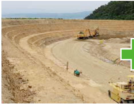
既設堤体掘削土
