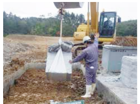
現場投入状況
