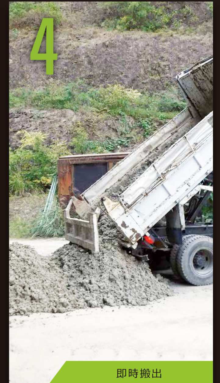
ダンプトラックに積み込み
