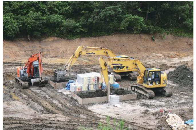
ポンテラン改良状況
