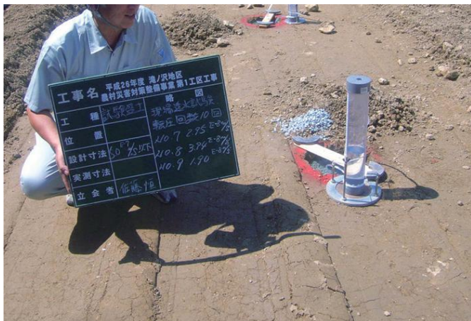
改良土品質確認（現場透水係数）
