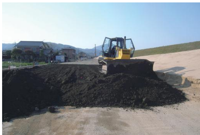
ポンテラン改良土敷均し状況
