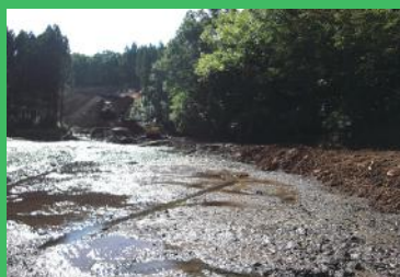
ため池底泥土
