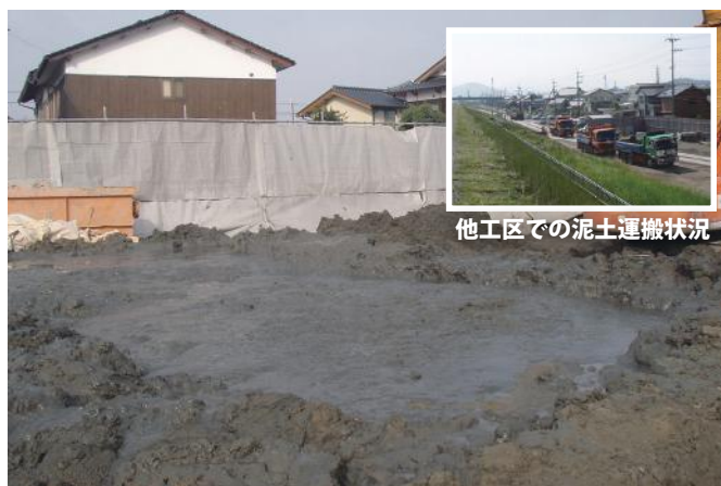
CDM 泥土排出状況
