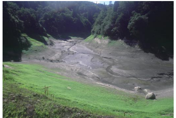
底泥土の堆積状況
