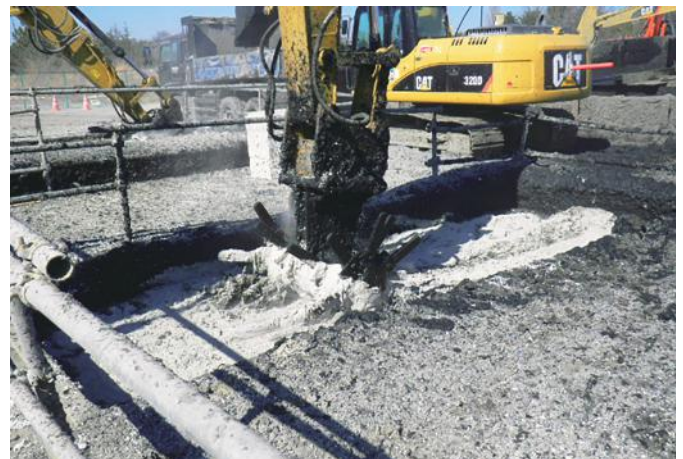
改良状況（セメント系固材混合）
