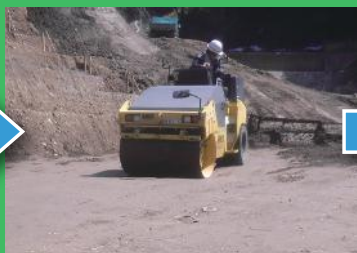
敷均し・転圧
