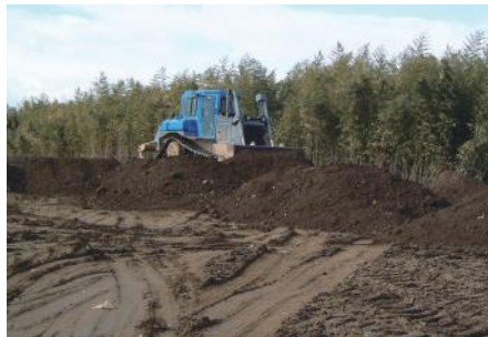
敷均し・転圧
