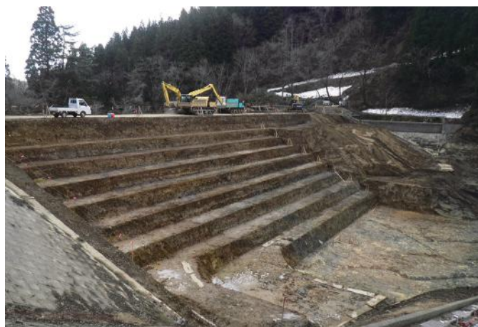
既設堤体段切り状況
