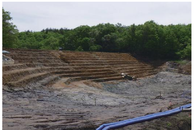
既設堤体段切り状況
