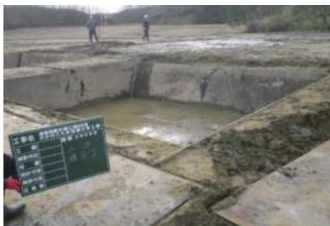
攪拌槽設置完了
