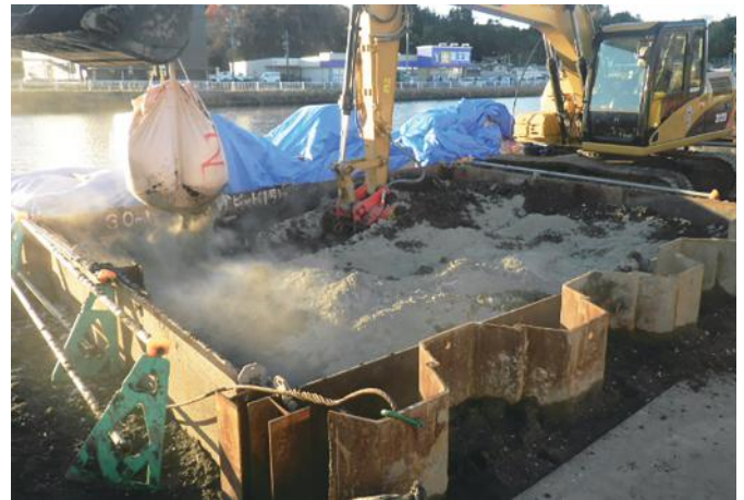
セメント系固化材混合状況
