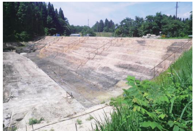
本施工 段切り完了
