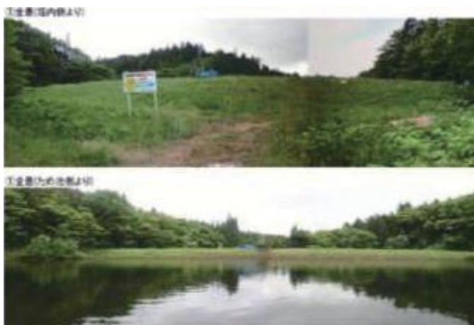
たかのこため池全景（着工前）
