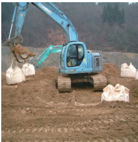
セメント添加状況
