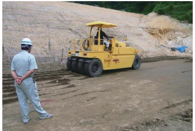
本施工 刃金土敷均し・締固め状況
