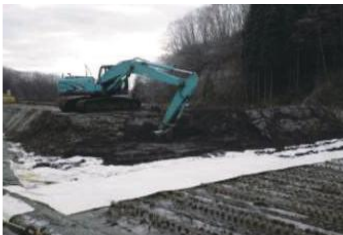
改良土の仮置き・整形状況
