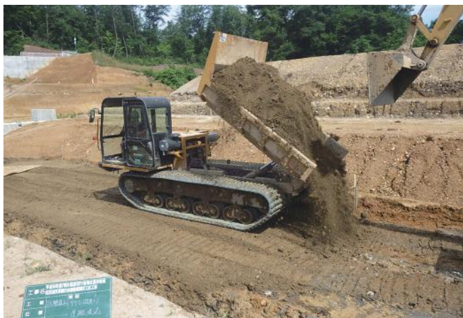
改良土運搬状況
