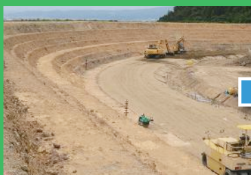
既設堤体掘削土
