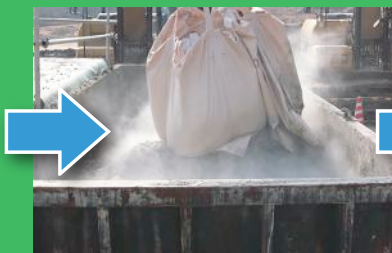
固化材投入・攪拌
