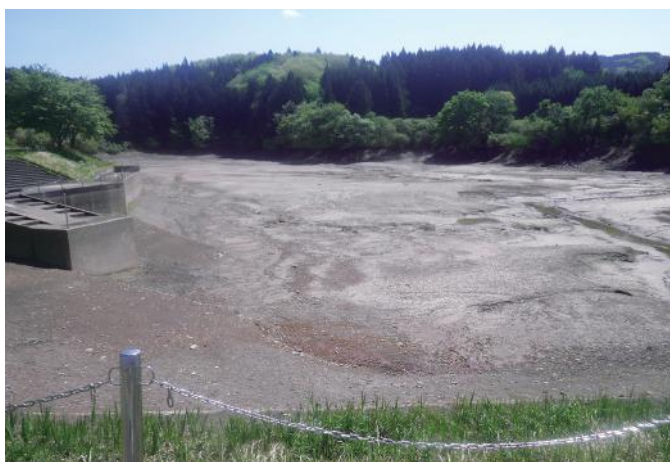
底泥土の堆積状況
