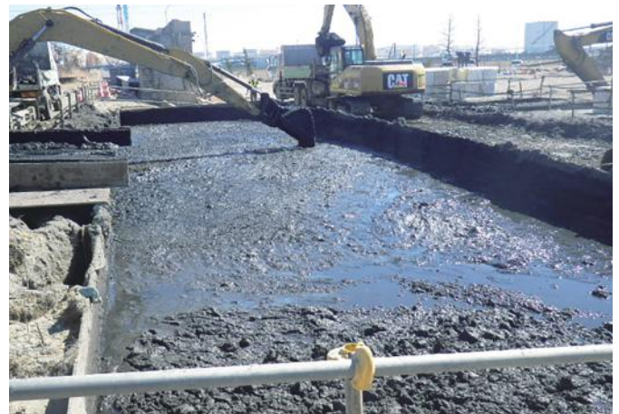
掘削土の状態（ヘドロ状）
