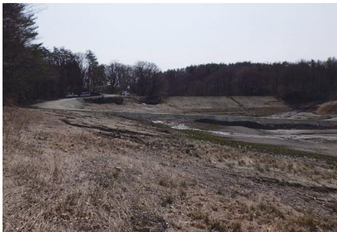
着工前の様子
