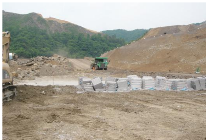
工事用道路に再利用
