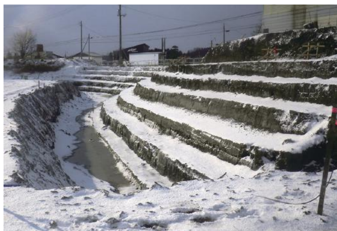
既設堤体段切り状況
