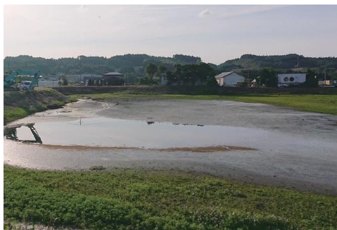
底泥土の堆積状況
