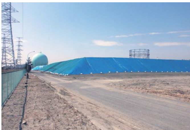
改良土仮置き状況
