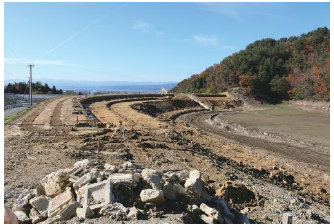
既設堤体段切り状況
