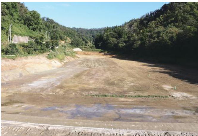
底泥土除去後の状況
