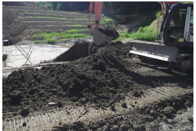
敷き均し状況
