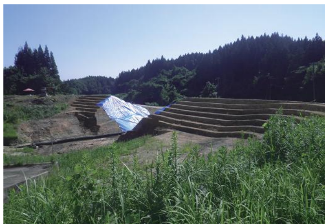
既設堤体段切り状況
