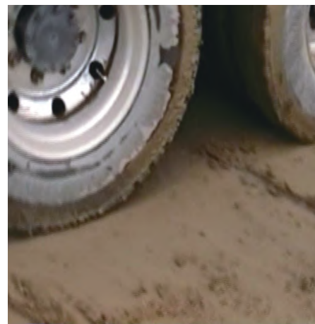
改良4時間後、ダンプトラック走行可能
