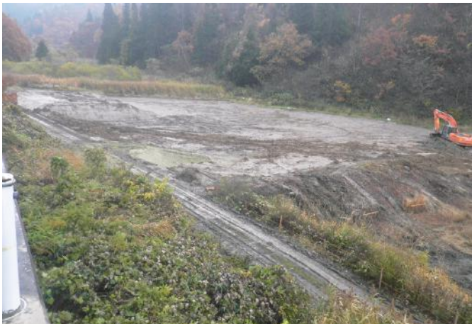
底泥土の堆積状況
