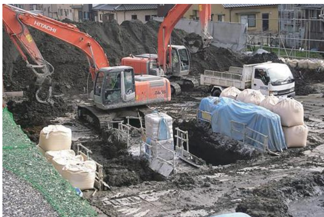
改良状況全景
