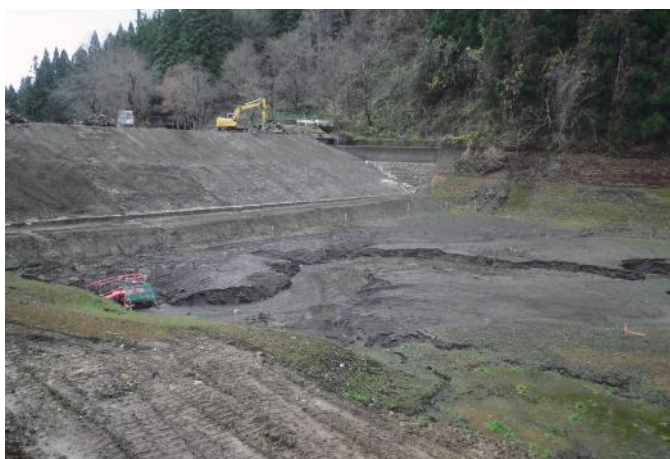
底泥土の堆積状況
