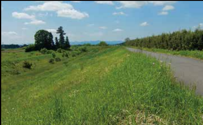
ポンテラン改良土 築堤箇所 (クラックなどの被害なし)
