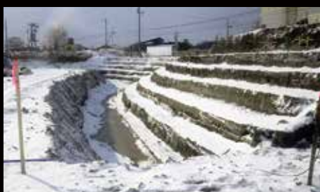
② 既設堤体段切り状況
