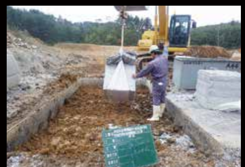
⑥ 現場投入状況
