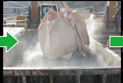
固化材投入・攪拌
