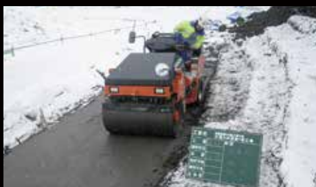
④ 転圧状況
