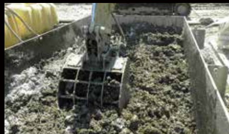
③ 改良状況
