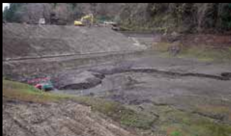
① 底泥土の堆積状況
