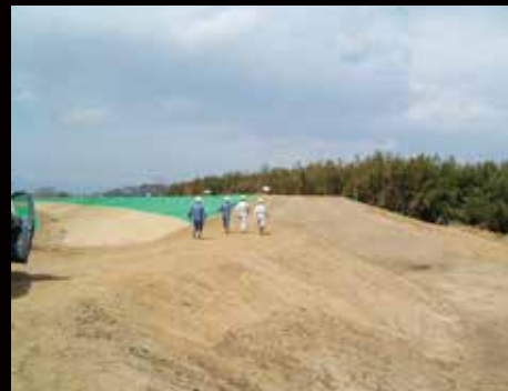
③ 築堤完成
