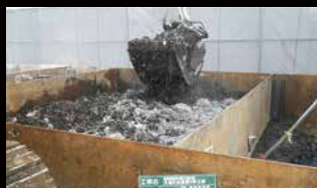
③ 改良状況
