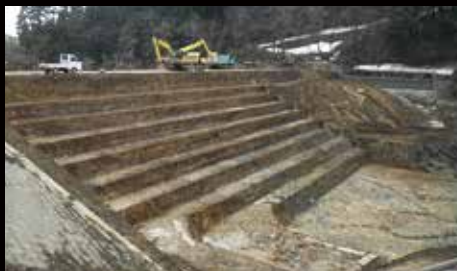
② 既設堤体段切り状況
