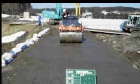
⑤ 転圧状況
