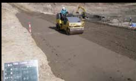
⑤ 転圧状況
