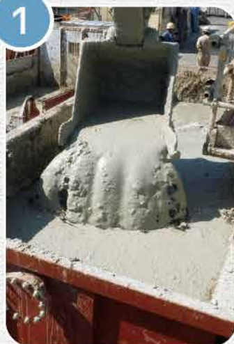
高含水泥土発生
