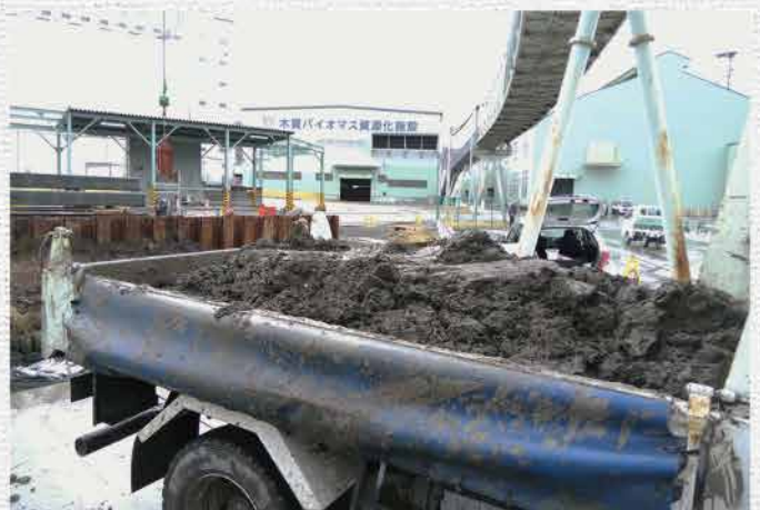
ダンプトラック積み込み
