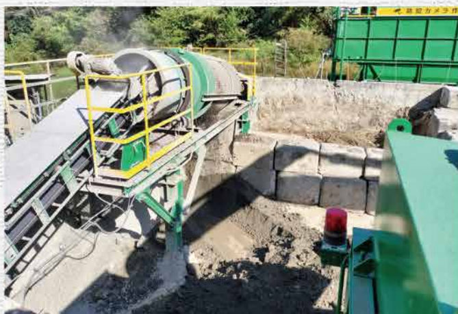
プラント稼働状況②
