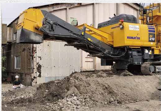
自走式土質改良機稼働状況
