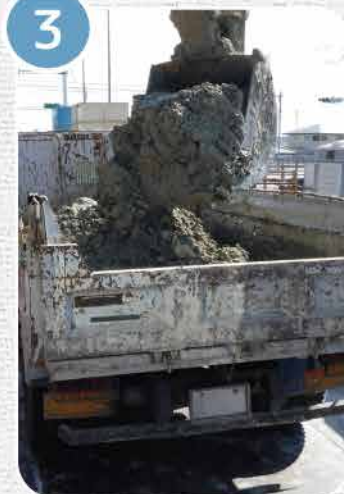
ダンプトラック積込み
