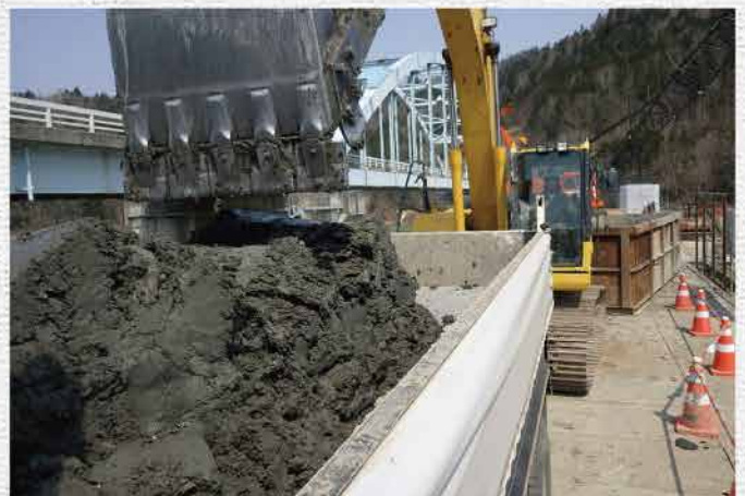
ダンプトラック積み込み
