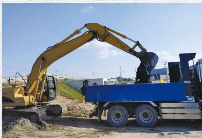
ダンプトラック積み込み
