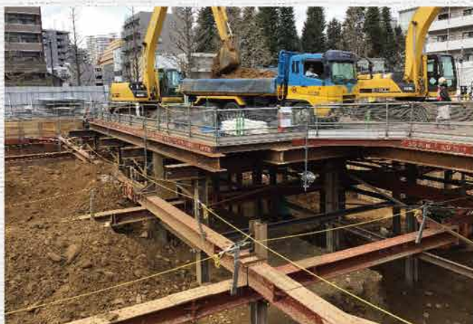
ダンプトラック積み込み
