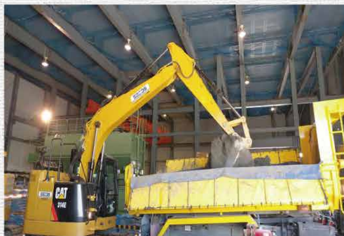
ダンプトラック積込み
