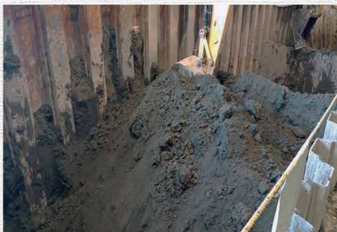
3時間養生後の状態
