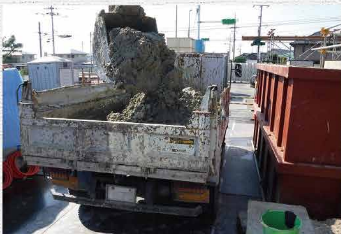
ダンプトラック積み込み
