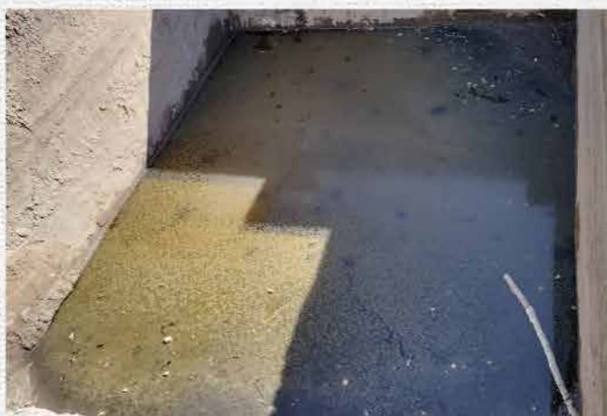
排水処理後の状態
