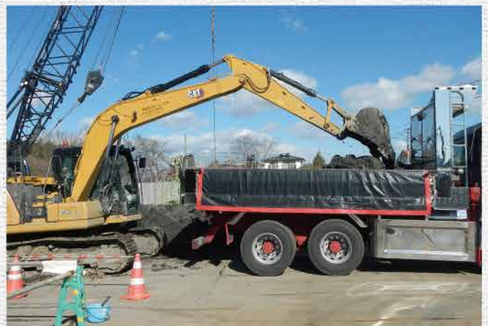
ダンプトラック積み込み
