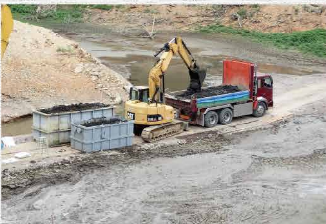
ダンプトラック積み込み
