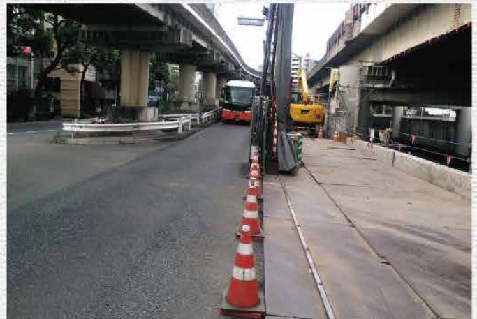
狭小な現場状況
