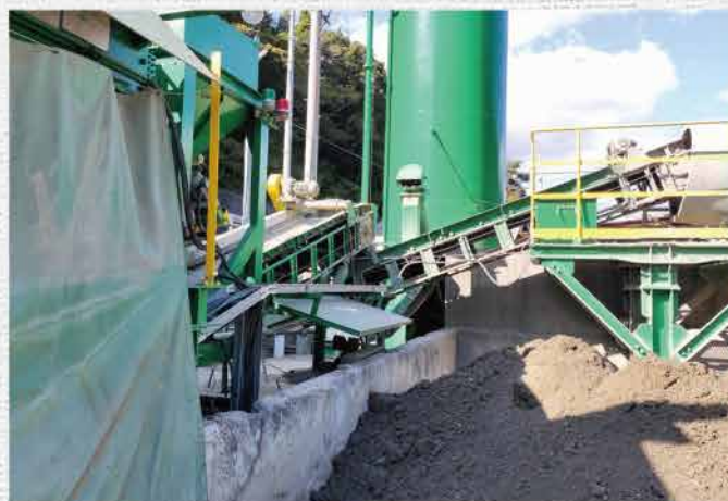
プラント稼働状況①
