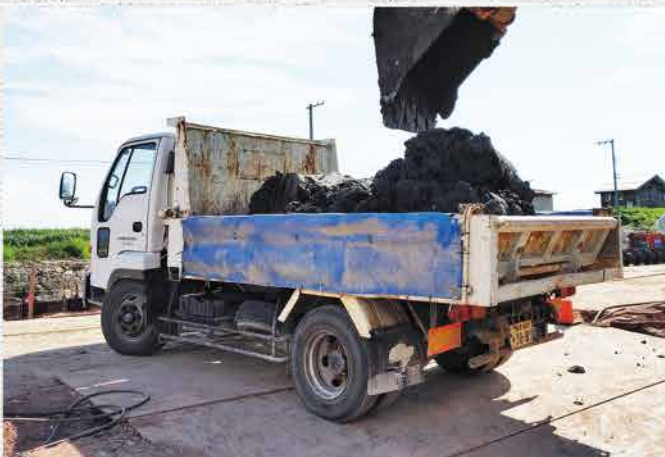
ダンプトラック積込み
