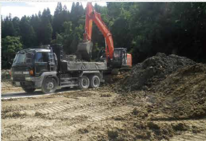
ダンプトラック積込み
