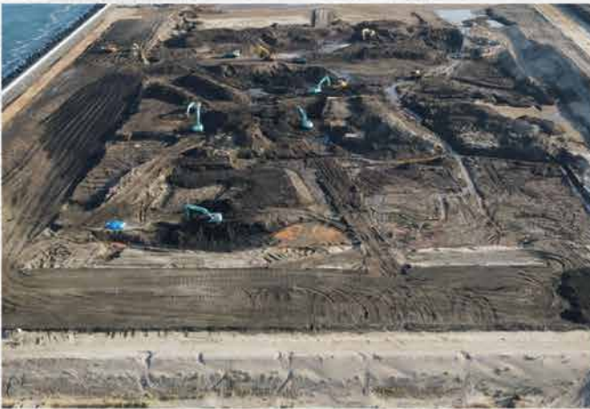
着工時現場全景
