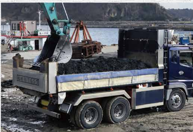
ダンプトラック積込み
