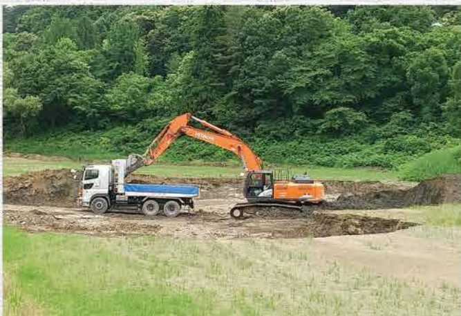
ダンプトラック積込み
