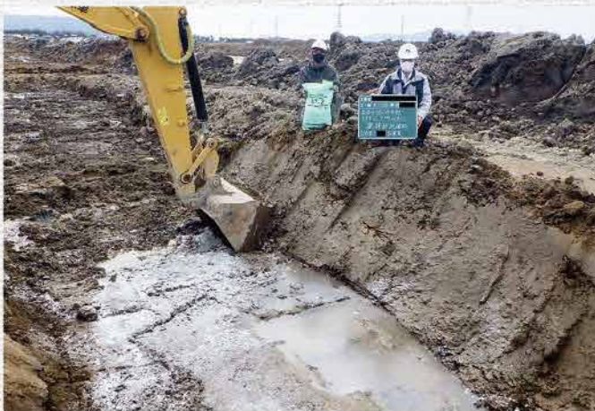
混合状況確認
