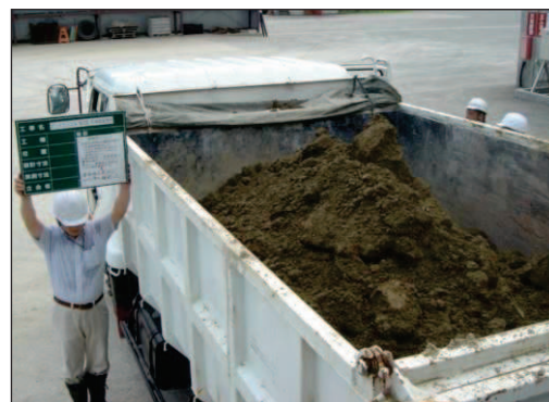
図-3 審査委員会立会いによる運搬性確認状況
