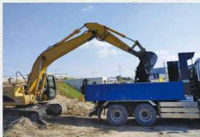
ダンプトラック積み込み
