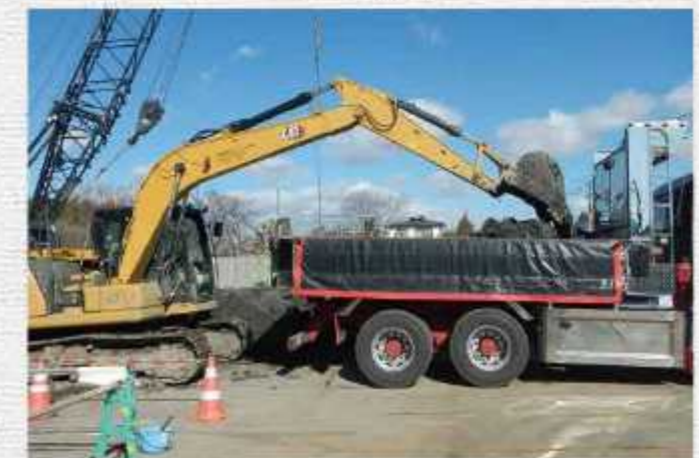
ダンプトラック積み込み
