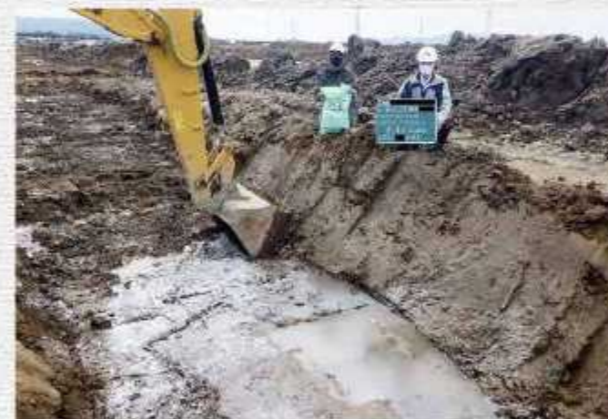
混合状況確認
