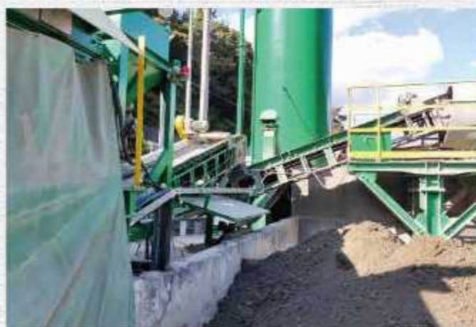
プラント稼働状況①
