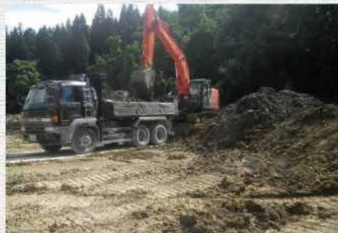
ダンプトラック積み込み
