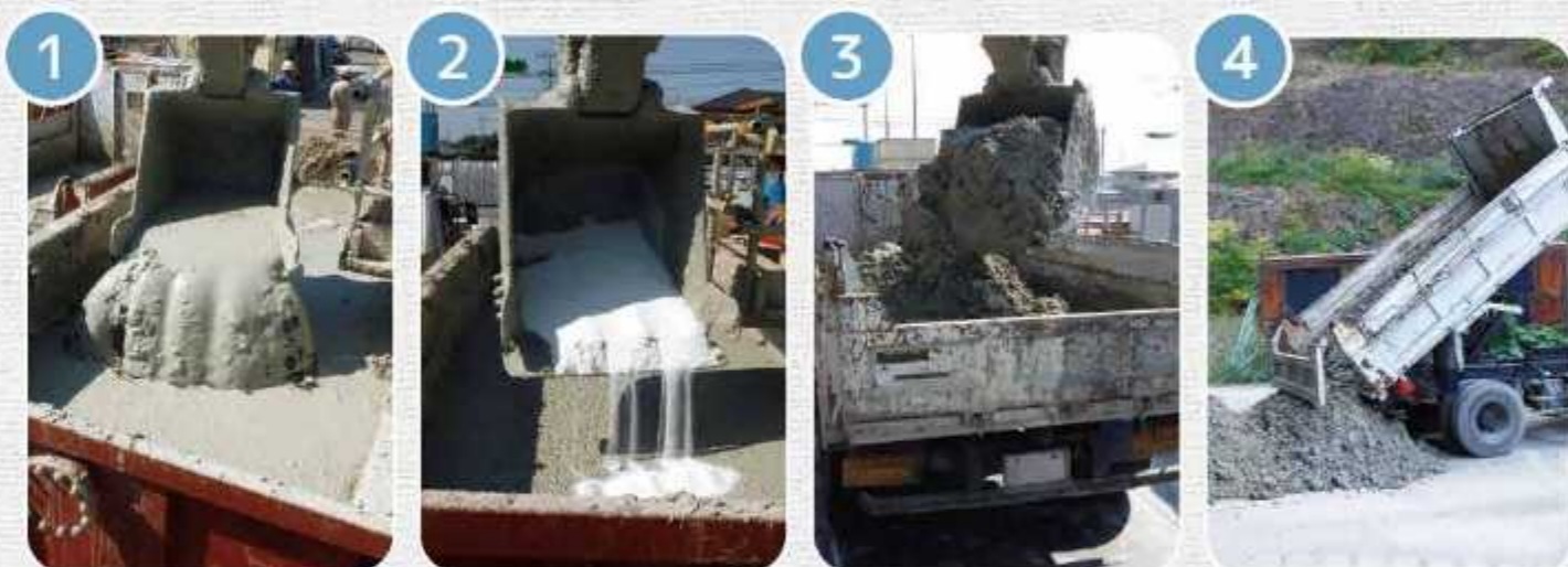
1 高含水泥土発生 2 MTシリーズ添加・混合 3 ダンプトラック積込み 4 即時搬出
