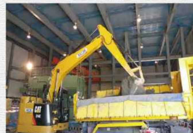
ダンプトラック積み込み
