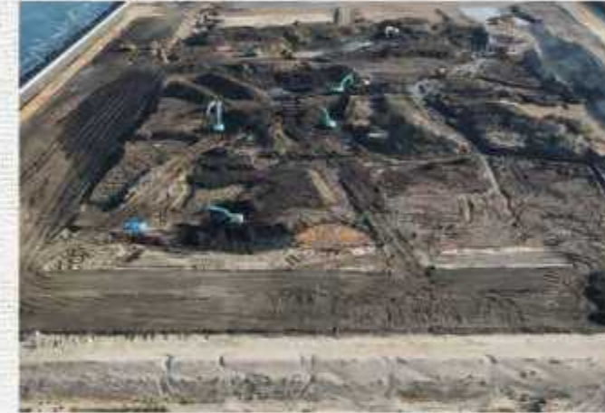
着工時現場全景
