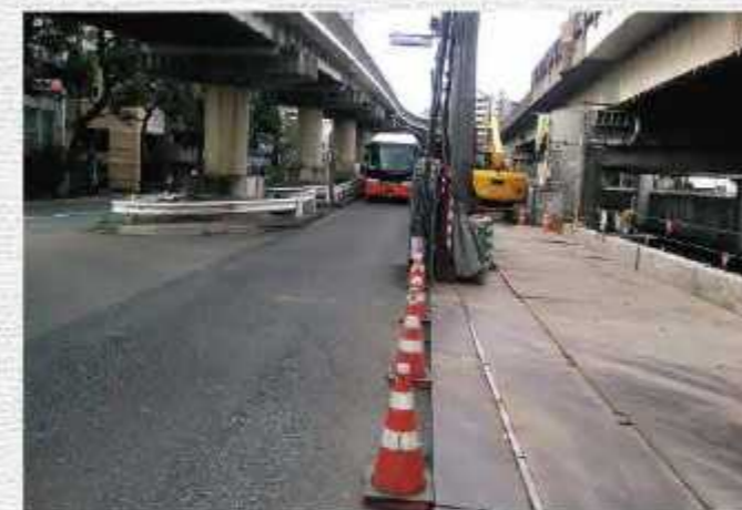
狭小な現場状況
