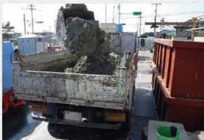
ダンプトラック積み込み
