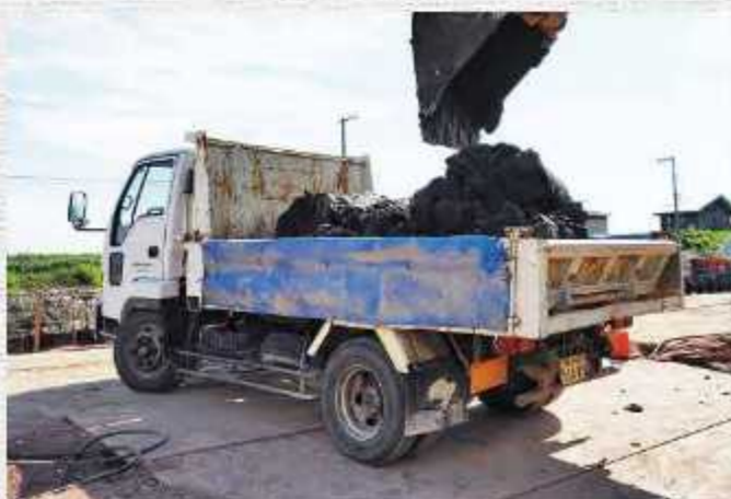
ダンプトラック積込み
