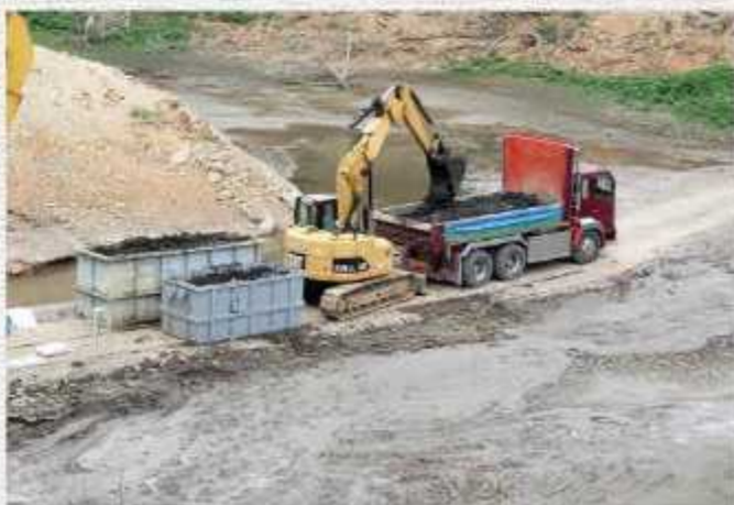
ダンプトラック積み込み
