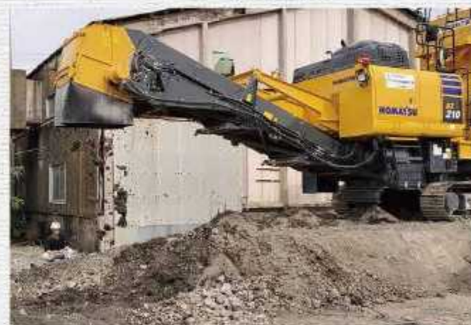
自走式土質改良機稼働状況
