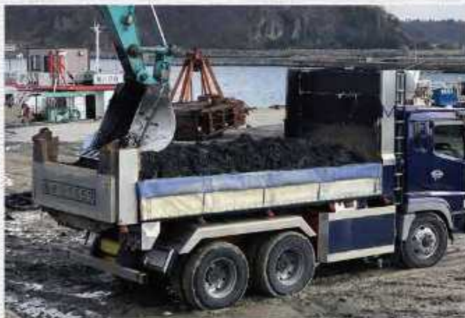
ダンプトラック積み込み
