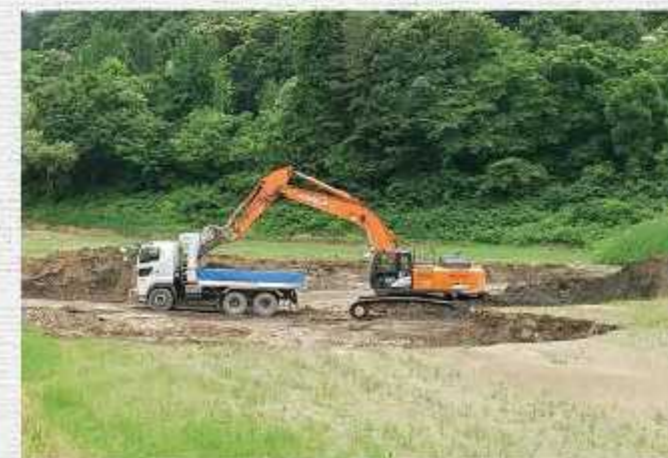
ダンプトラック積込み
