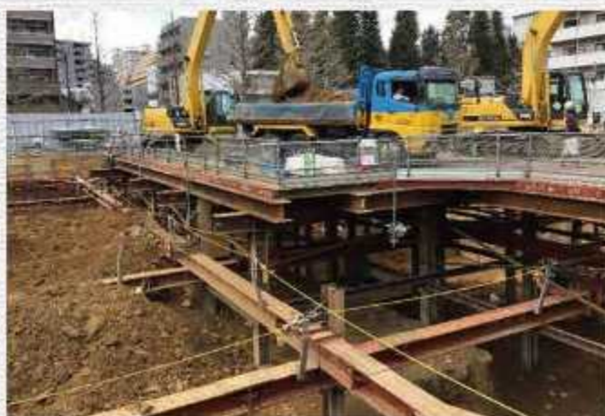
ダンプトラック積み込み
