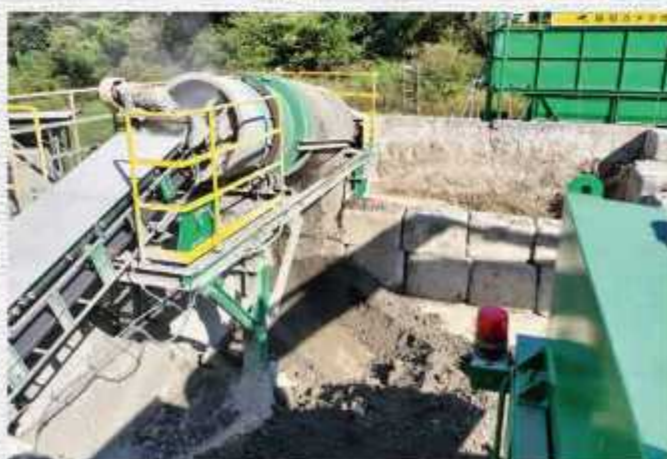
プラント稼働状況②
