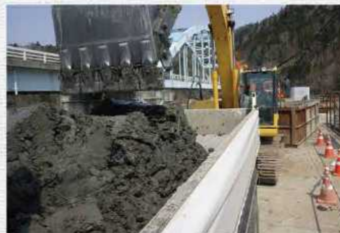
ダンプトラック積込み
