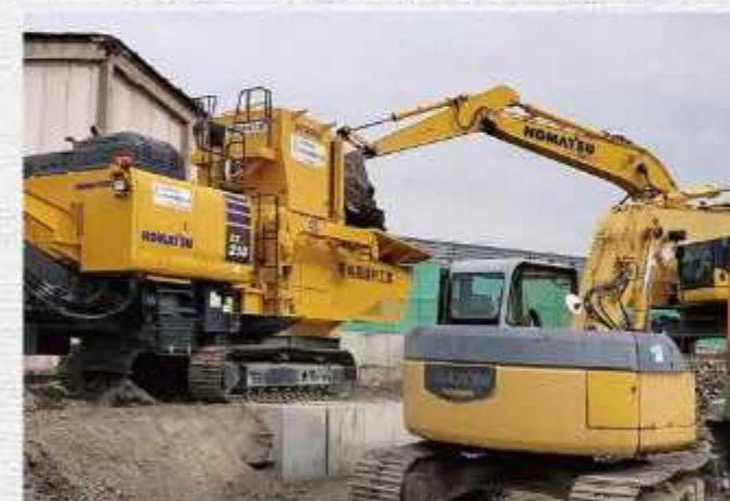
自走式土質改良機へ MT-2 改良土投入
