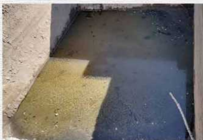
排水処理後の状態
