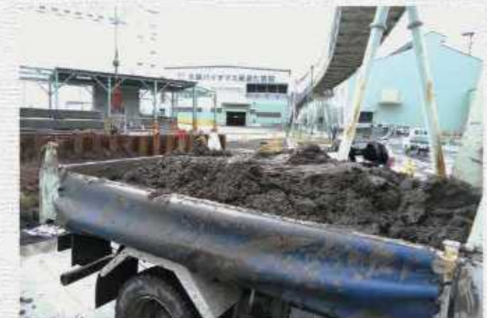
ダンプトラック積込み
