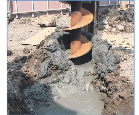
地盤改良・杭打ち泥土
