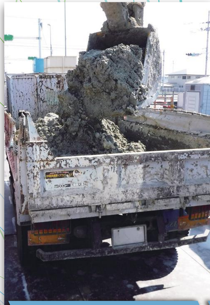
ダンプトラック積込み
