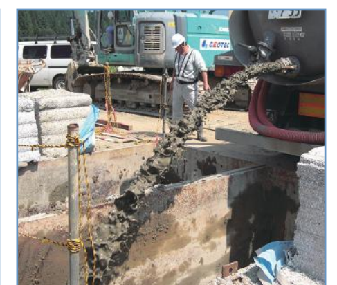
各種建設汚泥
