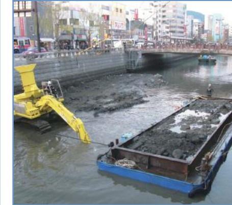
河川・港湾浚渫土
